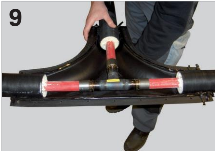
9 Anbringen des unteren Teiles der Halbschale. (Halbschale ohne Einfüllloch)
