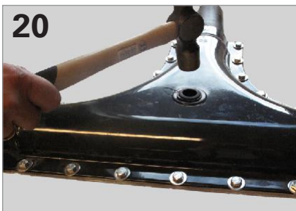
20 unteren Teiles des Expansionsstopfens in das Schaumloch einstecken, und einschlagen.
