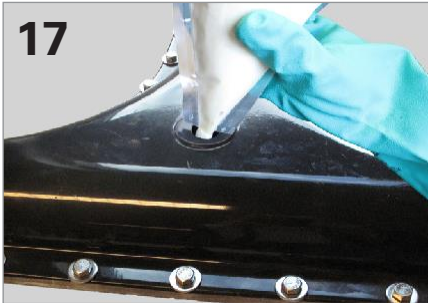
17 Einfüllen des Schaumes in die Halbschale.
