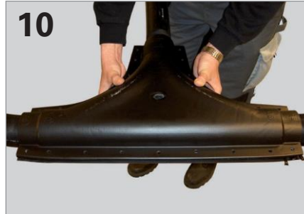
10 Anpassen des oberen Teiles der Halbschale. Umfangsband vorher 2x einlegen ! (Halbschale mit Einfüllloch)
